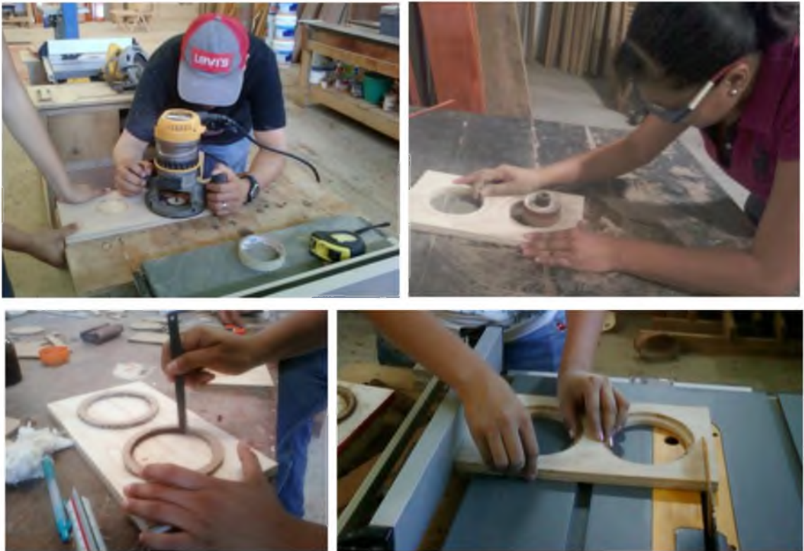
Figura 14. Fabricación de la cimbra de madera MDF, realización de corte y detallado de cada una de las piezas.
