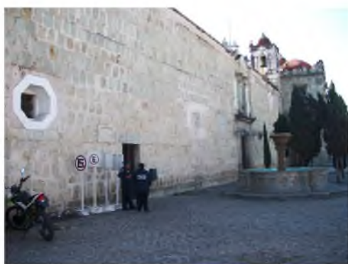
Figura 1.12: Entrada principal de la CCO. Fuente: Archivo propio.
