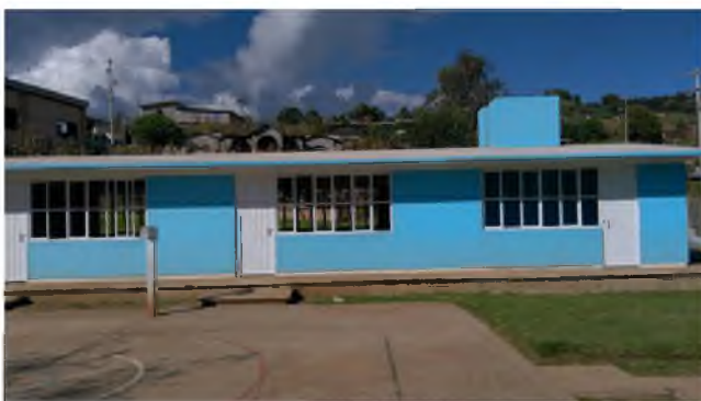
Figura 3.10: Preescolar Lázaro Cárdenas de San Martín Itunyoso. Fuente: Municipio de San Martín Itunyoso
