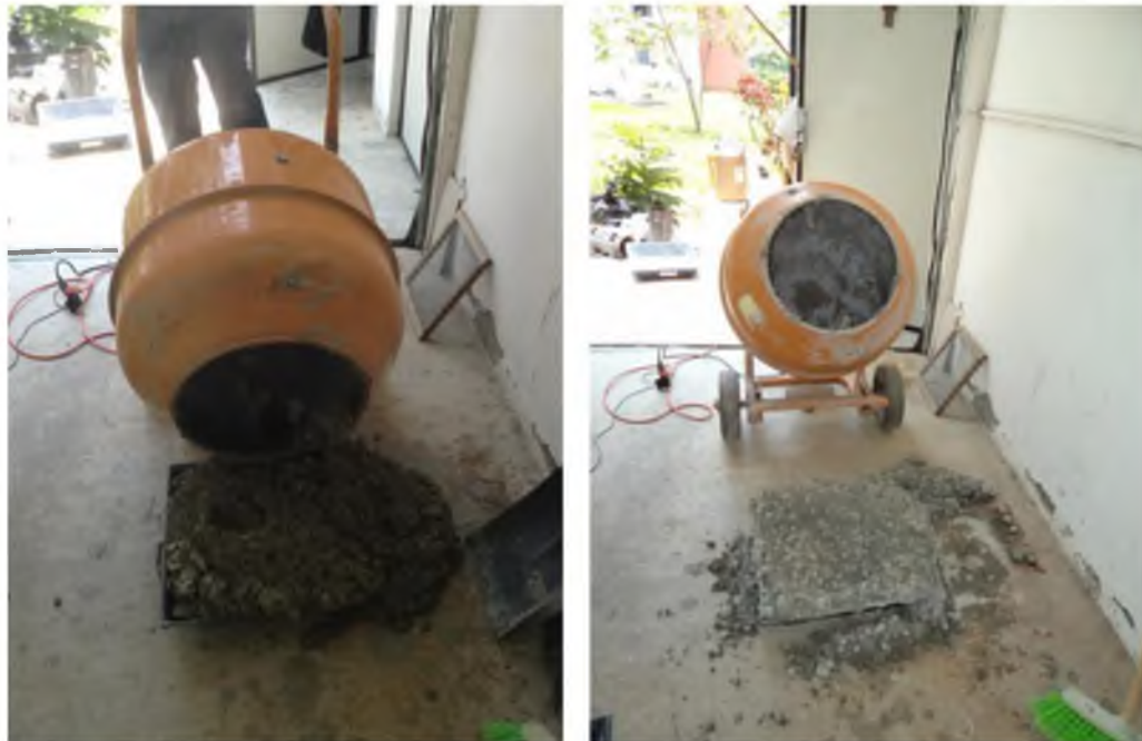
Fig. 2. Mezclado del material al 7% de polvo de aluminio.
