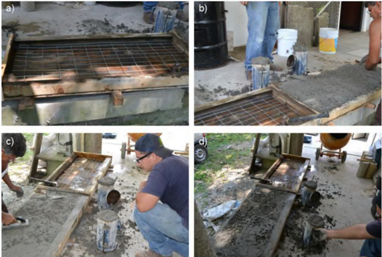
Fig.31 Elaboración de panel con refuerzo de malla electro soldada
