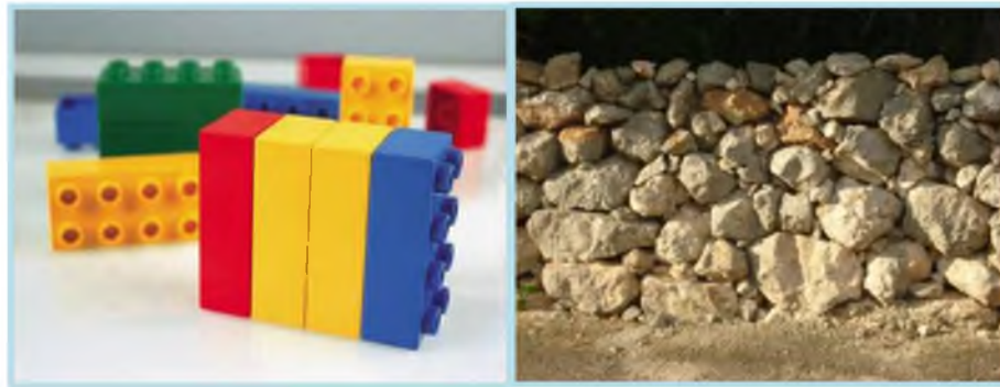
Figura 1. 1. Izquierda: Piezas de Lego [9]; Derecha: Foto tomada en Seye, Yucatán; rocas calizas sobrepuestas sin ningún cementante, calzadas con pequeñas cuñas
