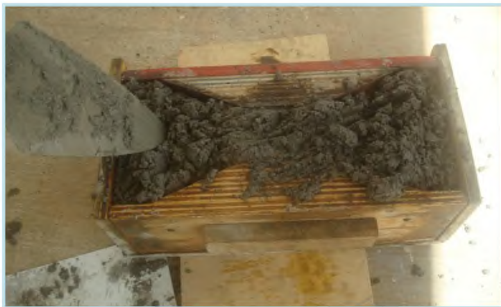
Figura 5.5. Vaciado del módulo moño.
