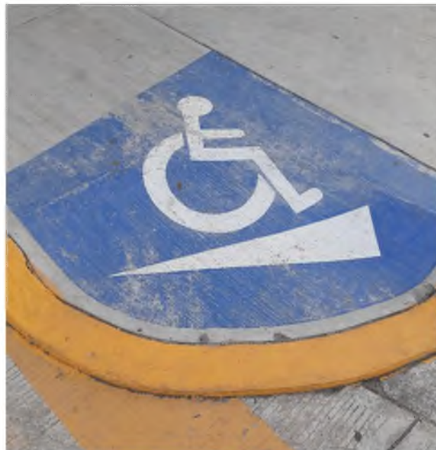
Figura 18. Rampas de accesos para minusválidos.
