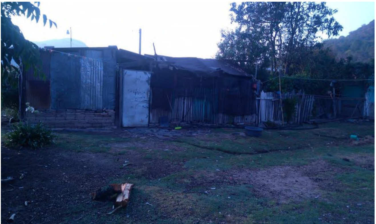
Figura 7 y 8. Casa de las informantes de Huautla de Jiménez. El material utilizado en la construcción de las viviendas es piso a base de tierra y cemento; para los muros (adobe y ladrillos) y para las techumbres (tela, loza o concreto y láminas). Fotografía de la autora.
