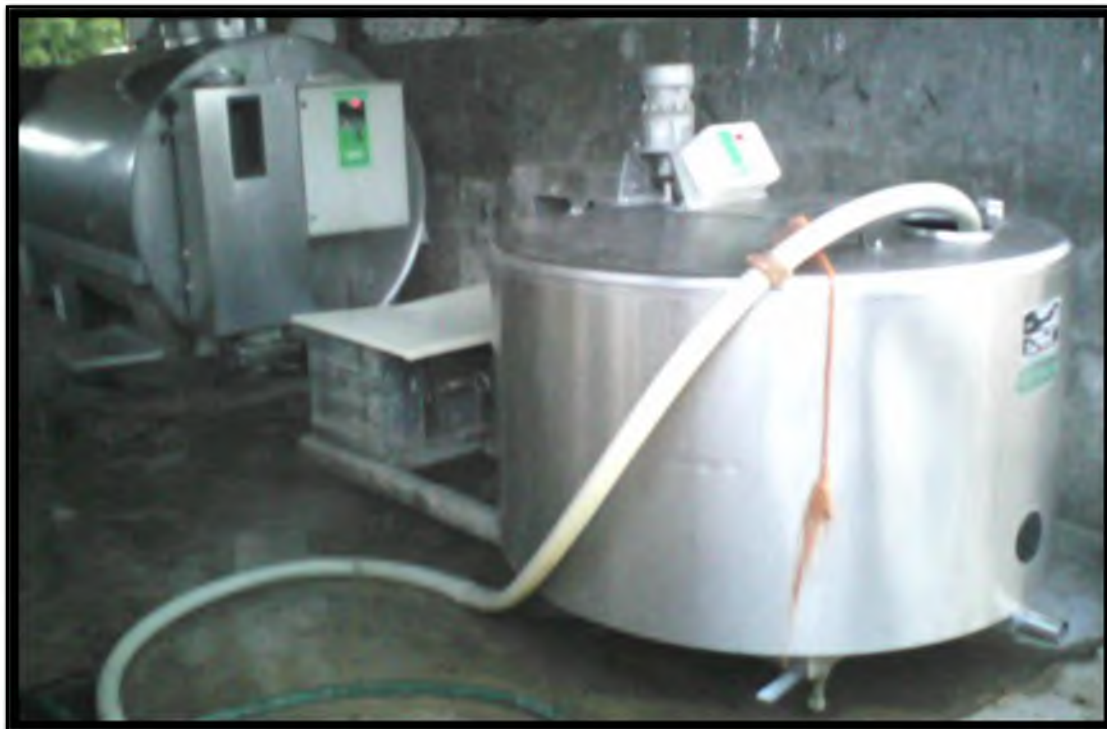
Tanque de refrigeración de la leche en la unidad de producción.
