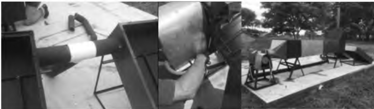
Fig. 2.10 Instalación del secador solar.
