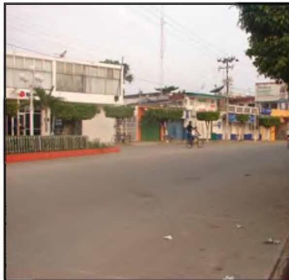
Figura 8. Textura uniforme en el pavimento
