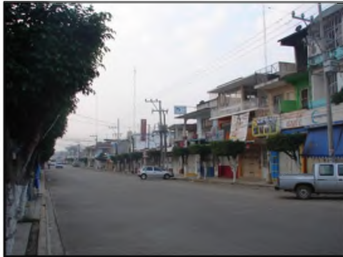
Figura 21. Vista desde la av. Morelos hacia la av. 16 de Septiembre
