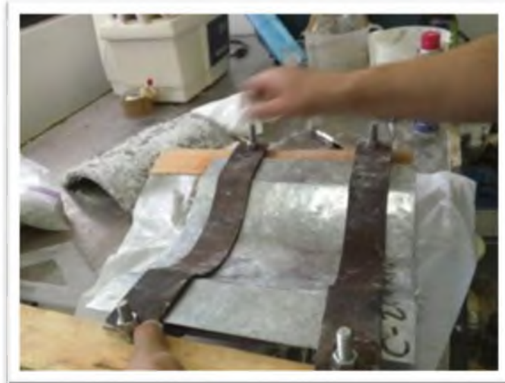
Fig. 41. Fabricación del molde con lámina de acero inoxidable y cinchos. Fuente: Propia.
