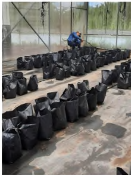
Figura 24. Instalación del sistema de riego.
