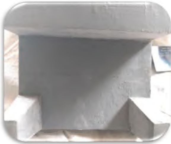
Figura 43. Aplicación de plaster parte inferior
