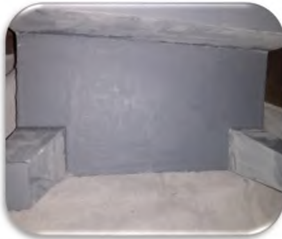
Figura 47. Aplicación de plaster y lijada de plaste parte inferior
