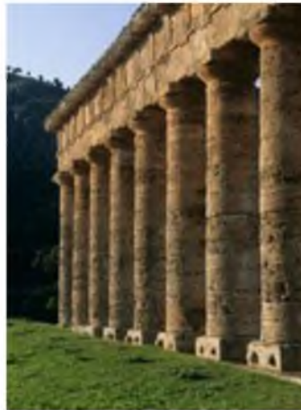
Figura 5: Columnas de una construcción
