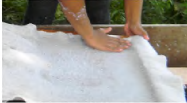
Figura 40: Colocación del fieltro
