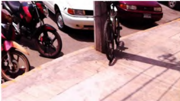
Figura 17: Poste de alumbrado público utilizado para asegurar bicicletas.
