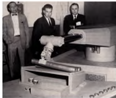
Figura 2: Robot Unimate de aplicación industrial, puesto en marcha por General Motors en 1961.
