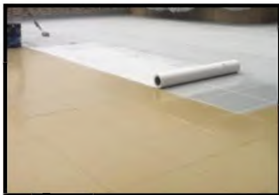
Figura 3.3 Membrana de refuerzo impermeabilizante para proteger los tableros de OSB.
