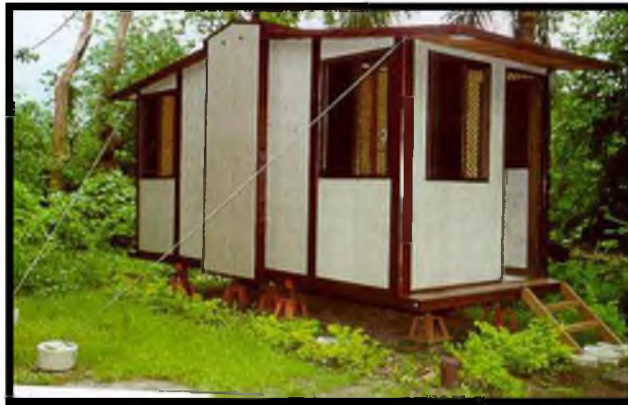
Figura 1.2 Prototipo elaborado de la casa F, en la República de Filipinas. Foto FPRDI. Se destaca el uso de los paneles industrializados con su medida estándar, evitando el coste por cortes caprichosos para la estructura.
