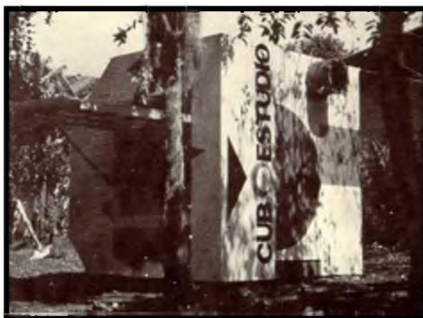
Figura 1.1 Módulo habitacional industrializado. Las características de su forma geométrica darán pautas en el diseño para el acoplamiento de manera modular en el terreno.
