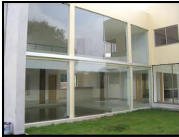
Figura 3.8 Ejemplo de uso del vidrio templado en una fachada.
