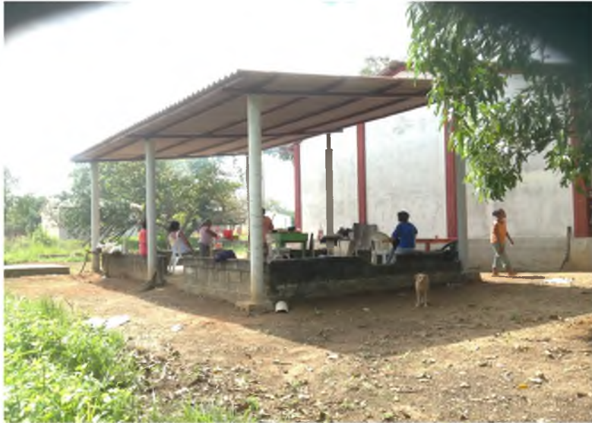
Foto 5. Vista panorámica del comedor "20 de Noviembre". Fuente: Por autor.
