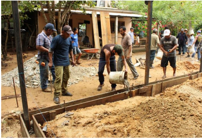
Figura 4. Preparativos para la colocación de guarnición del laboratorio
