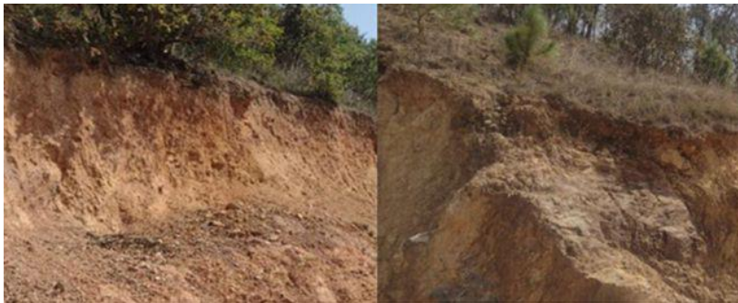
Figura 1. Suelos erosionados, el Duraznal 2024.
