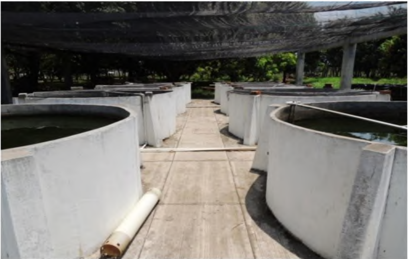
Figura 4. Sistema de estanques de ferrocemento de 3 m de diámetro adicionada con agua verde.
