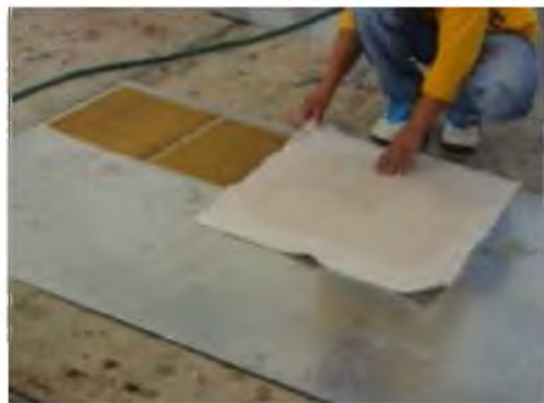
Figura 3.16 Colocación de fieltro.
