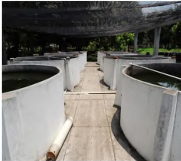
Figura 8: Estanques de ferrocemento de la unidad Acuícola de la Universidad del Papaloapan.
